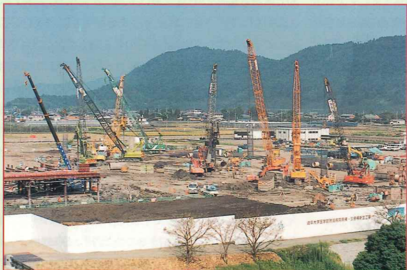
工事現場全体
