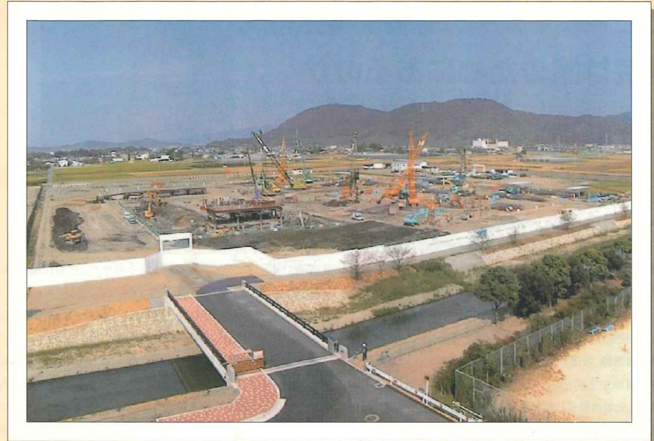
岐阜大学医学部附属病院新営工事現場 全景南東面(平成12年8月26日現在)
